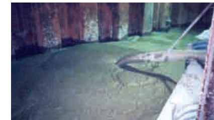
流動化処理土流し込み
